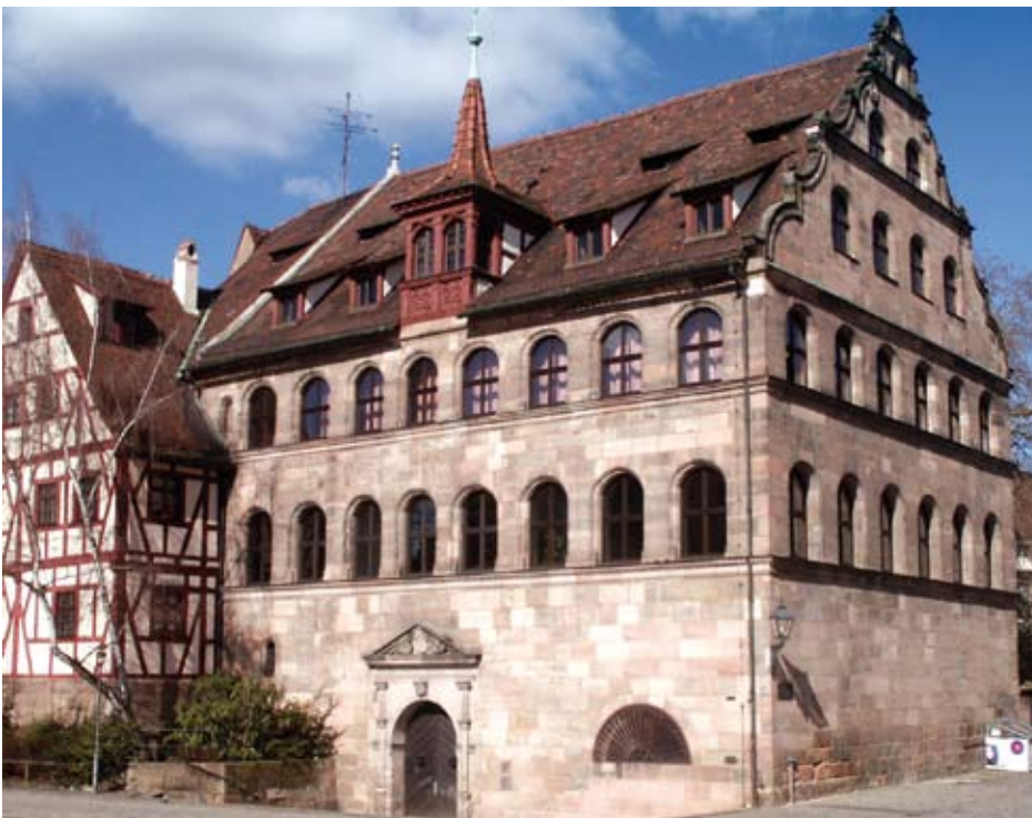
Nürnberg Bildungszentrum, Exemplarische Innendämmung denkmalgeschützter Bausubstanz
