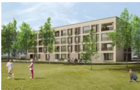
Neu-Ulm: energieeffiziente Gebäudehülle in monolithischer Bauweise mit hochwärmege-dämmten Ziegeln und innovativer Verglasung, Architekten: GlassX AG, Zürich
