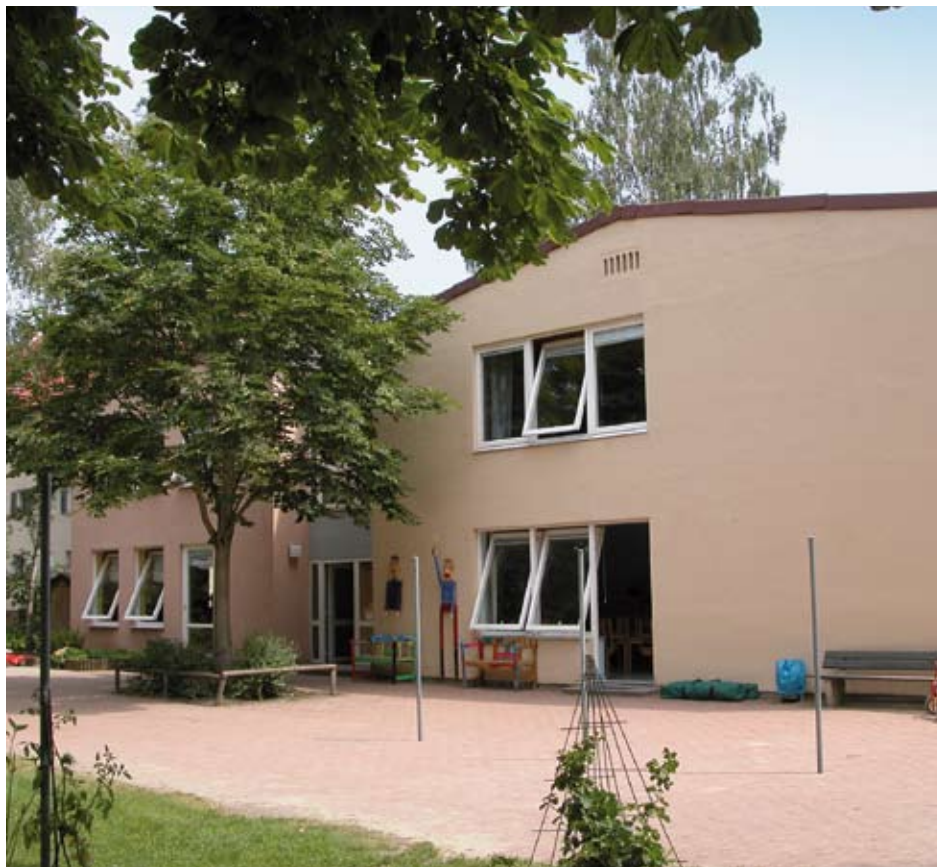
Kindergarten Immelmanstraße in Augsburg vor der energetischen Sanierung
