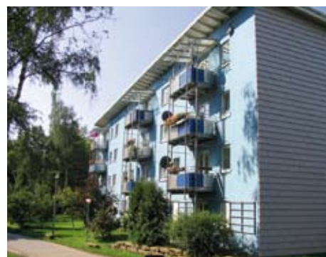
Forchheim-Nord: Synergieeffekte durch Anschluss der Neubauten an bestehende Heizanlagen. Architekten: Ebe+Ebe, München
