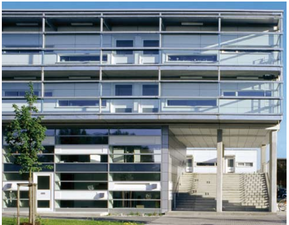
Ingolstadt-EUROPAN: Kombination von passiver und aktiver Sonnenenergienutzung Architekten: Blauwerk Architekten, München
