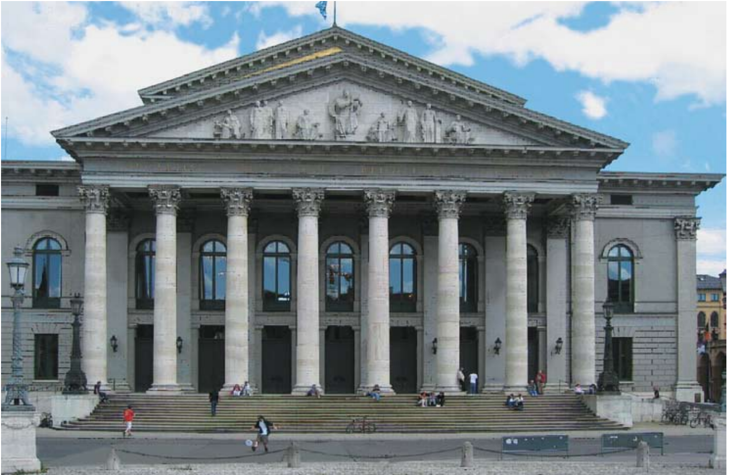
Energiemanagement für die Bayerische Staatsoper, München Quelle: Staatliches Bauamt München 1
