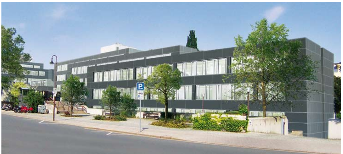
Generalsanierung Technisches Ämtergebäude Bayreuth, Straßenansicht Grafik: Architekten Dömges und Partner
